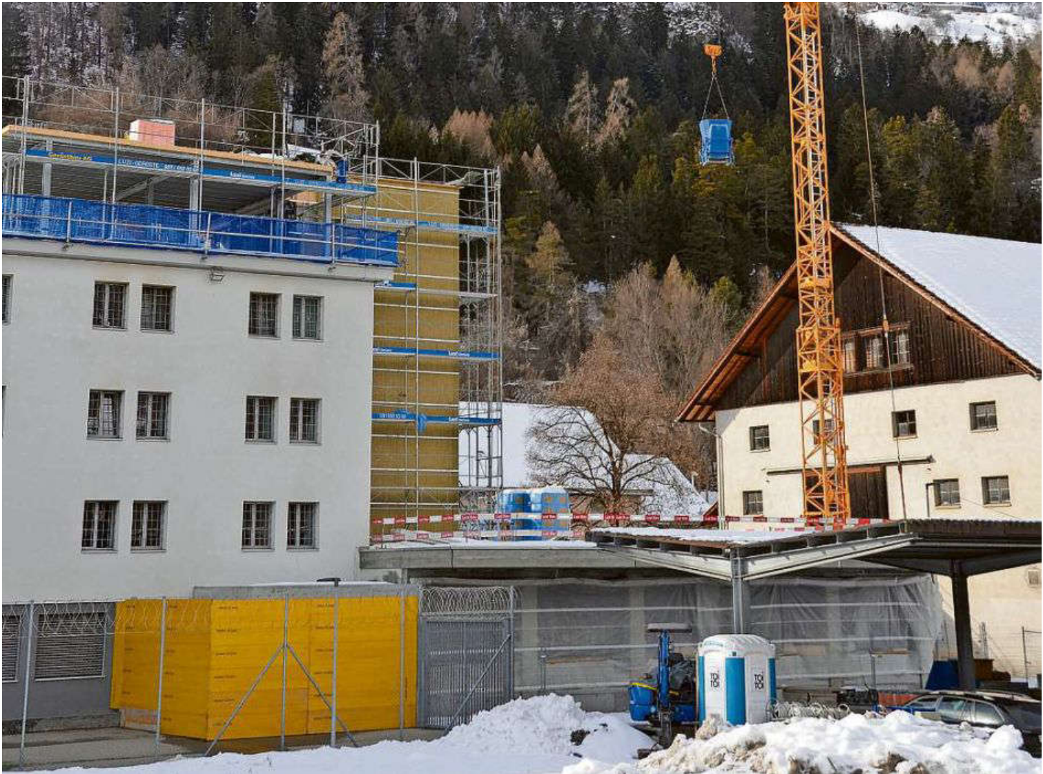
Zwischen der JVA Realta und der JVA Tignez entsteht die neue Übertrittsabteilung.
